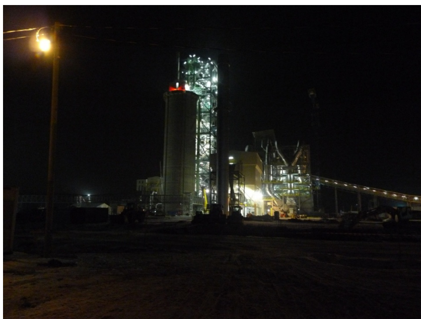
Obr. Noční pohled na cementárnu
