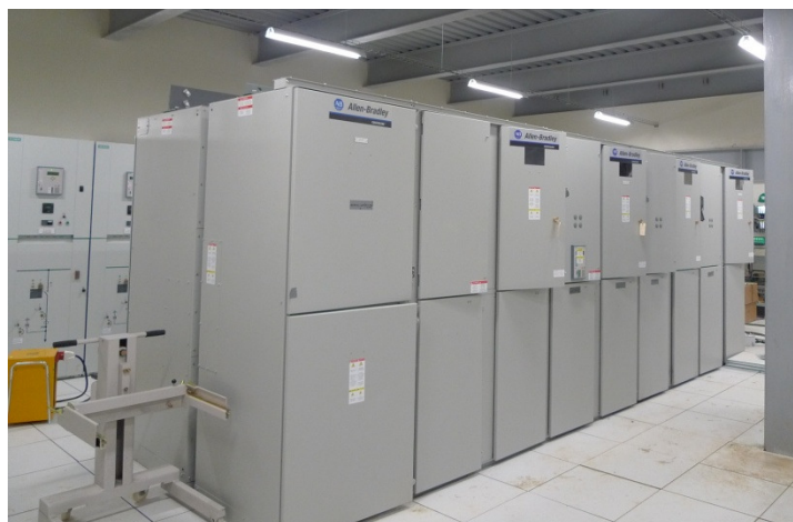
Obr. Surovinový mlýn: VN Měnič kmitočtu, chlazený kapalinou, 4,5MW, 6,3kV; sestava vstupních, výstupních polí a pole by-passu (obrázek vpravo)
