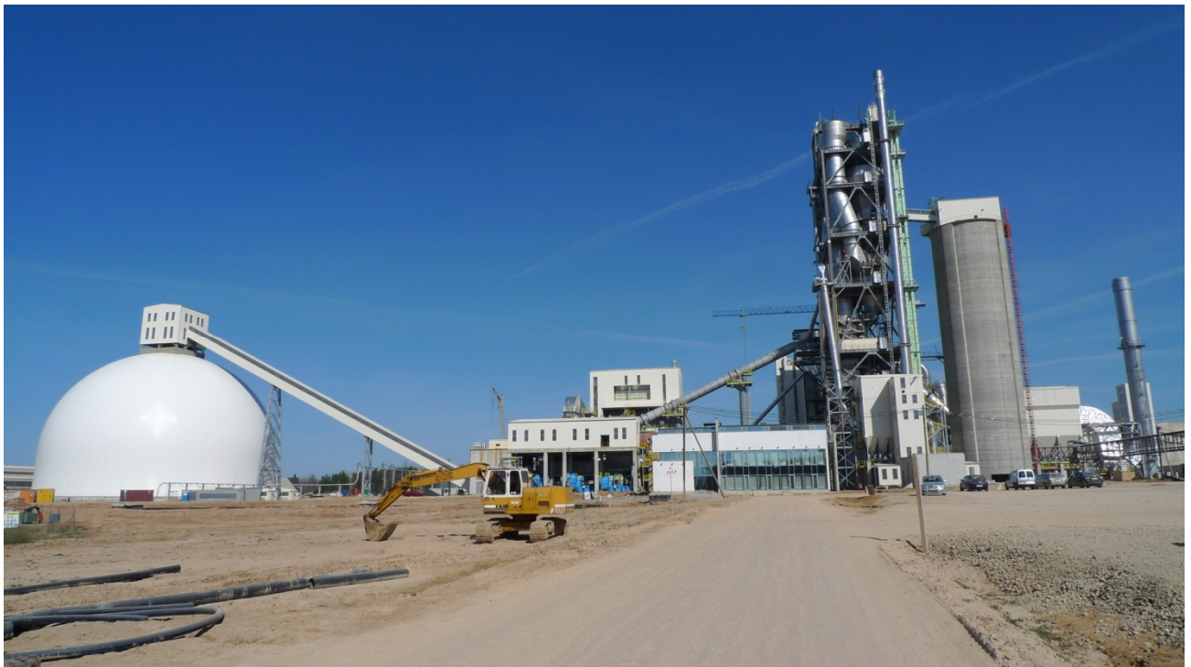
Obr. Celkový pohled na cementárnu: Předehříváč a surovinové silo (vpravo), objekt filtru (vpravo v pozadí), budova řídicího střediska a objekt chladiče slínku (uprostřed), zásobník slínku (vlevo),
