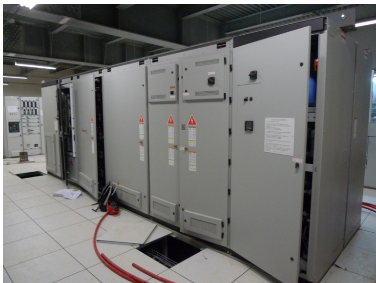
Obr. Surovinový mlýn: VN Měnič kmitočtu, chlazený kapalinou, 4,5MW, 6,3kV; sestava vstupních, výstupních polí a pole by-passu (obrázek vpravo)
