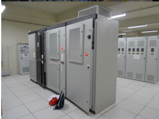
Obr. Chladič slínku : VN Měníč kmitočtu, chlazený vzduchem, 1000kW, 6,3kV; technologie (v pozadí)
