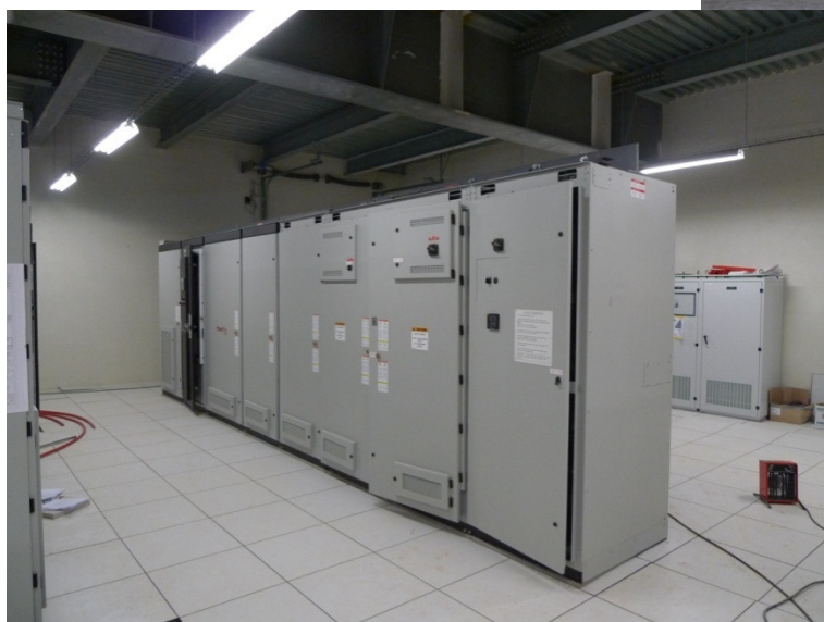
Obr. Přeohříváč: Věž přeohříváče (4 stupně) a pohled na rotační pec (vlevo); ventilátor přeohříváče 3,8MW (vpravo) a VN měnič kmitočtu pro jeho pohon (dole).
