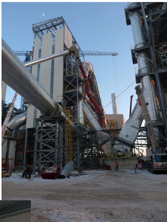
Obr. Přeohříváč: Věž přeohříváče (4 stupně) a pohled na rotační pec (vlevo); ventilátor přeohříváče 3,8MW (vpravo) a VN měnič kmitočtu pro jeho pohon (dole).
