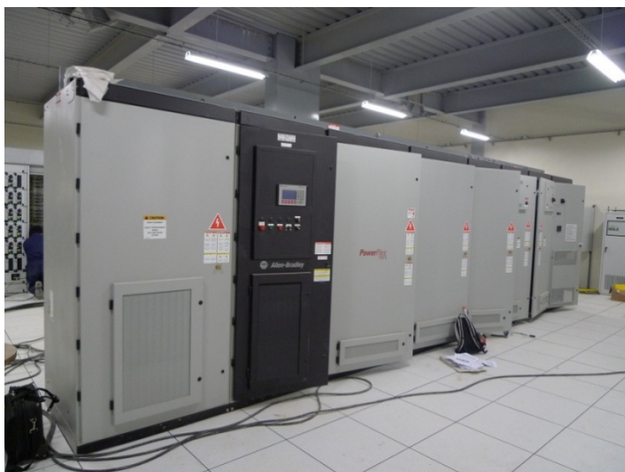
Obr. Surovinový mlýn: VN Měnič kmitočtu, chlazený kapalinou, 4,5MW, 6,3kV; sestava vstupních, výstupních polí a pole by-passu (obrázek vpravo)
